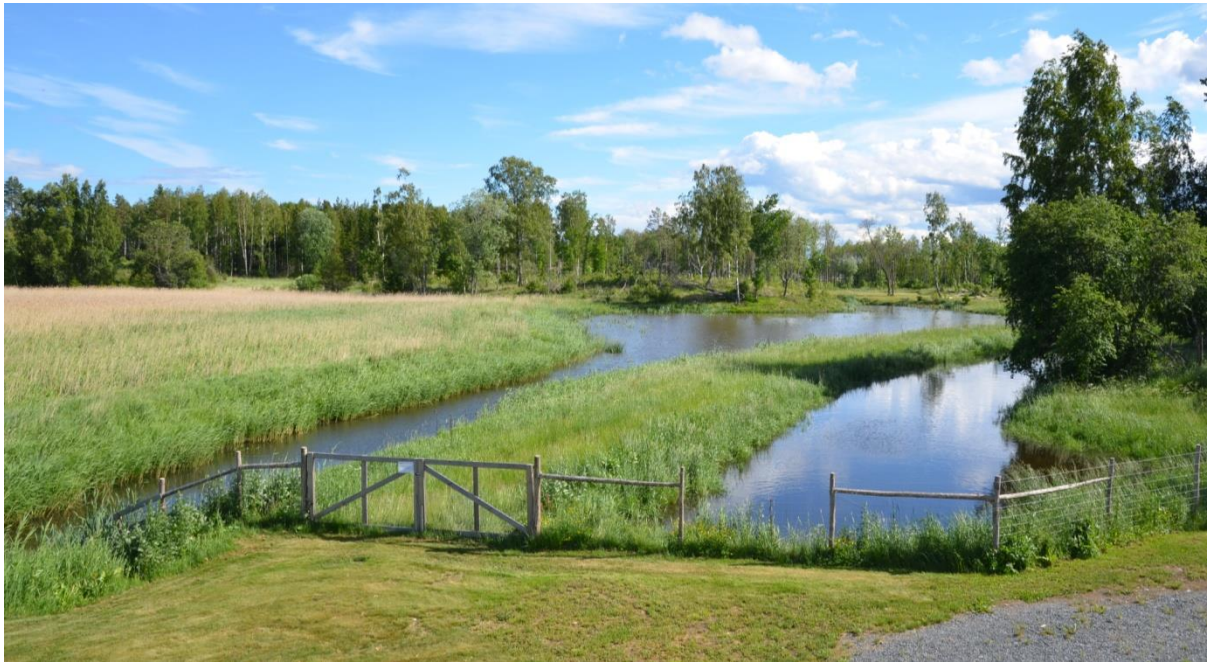
Figur 3-4. Ett exempel på ett efterbehandlingssteg är Karö Våtmark som efterbehandlar avloppsvatten från Östhammars avloppsreningsverk. Till höger ligger en av flera grunda dammar för kväveretention där vattenståndet varierar i cykler över dygnet och dammen till vänster innehåller färdigbehandlat vatten. Utloppet till Östhammarfjärden ligger längst bort i bild.
