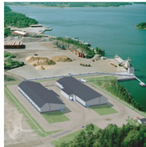
Mottagningsanläggning i Hargshamn
