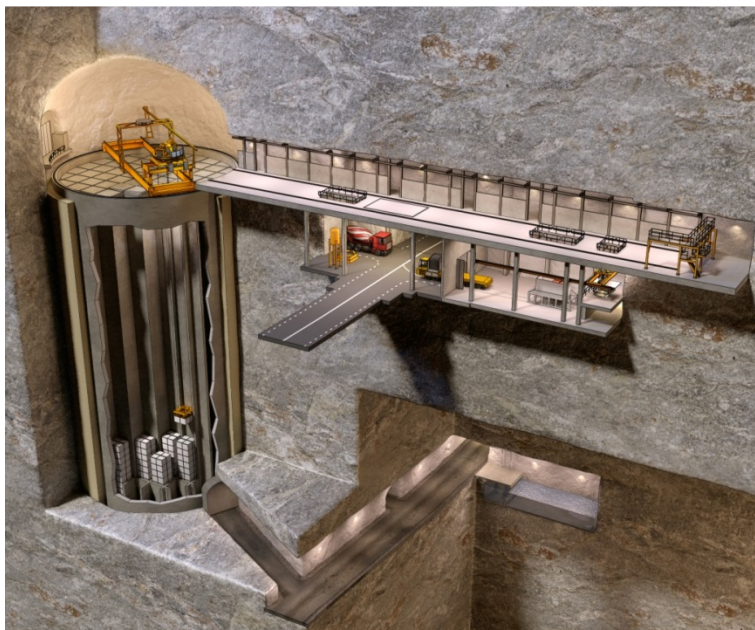
Figur 5-3. Siloförvaret i befintligt SFR under driftskedet.
