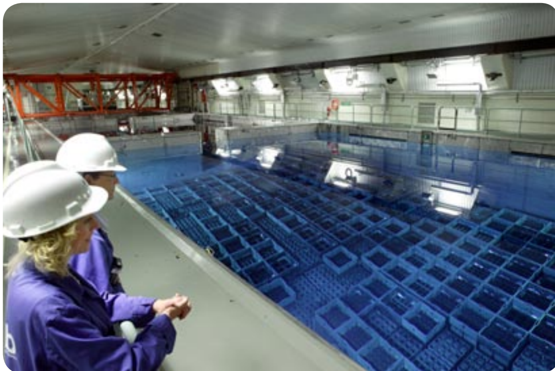
Figur 3-6. Övervakad våt mellanlagring av använt kärnbränsle i Clab.
