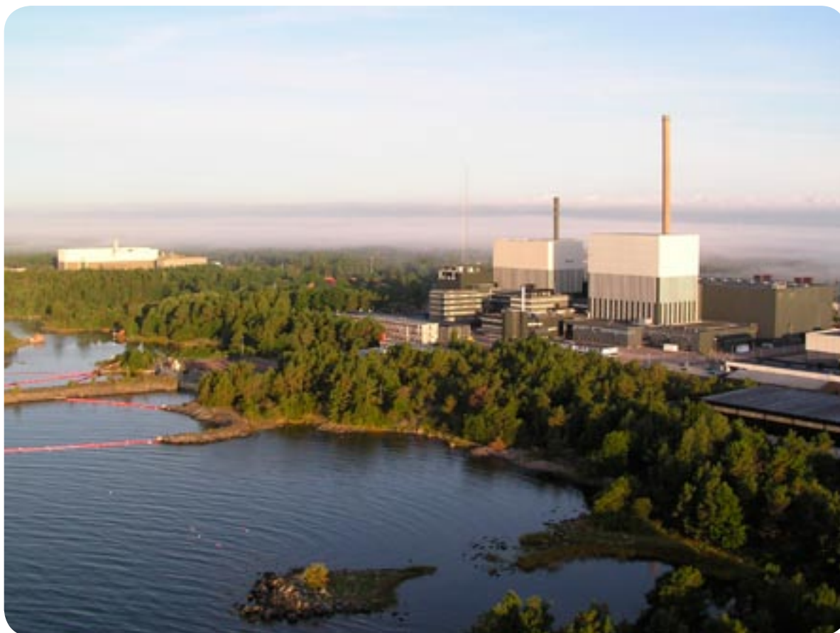
Figur 7-52. Kärntekniska anläggningar i Simpevarp.
