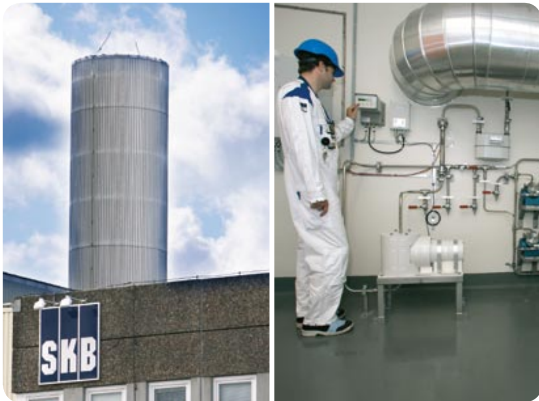
Figur 8-15. Clabs huvudskorsten och mätutrustning för aktivitetsutsläpp till luft.
