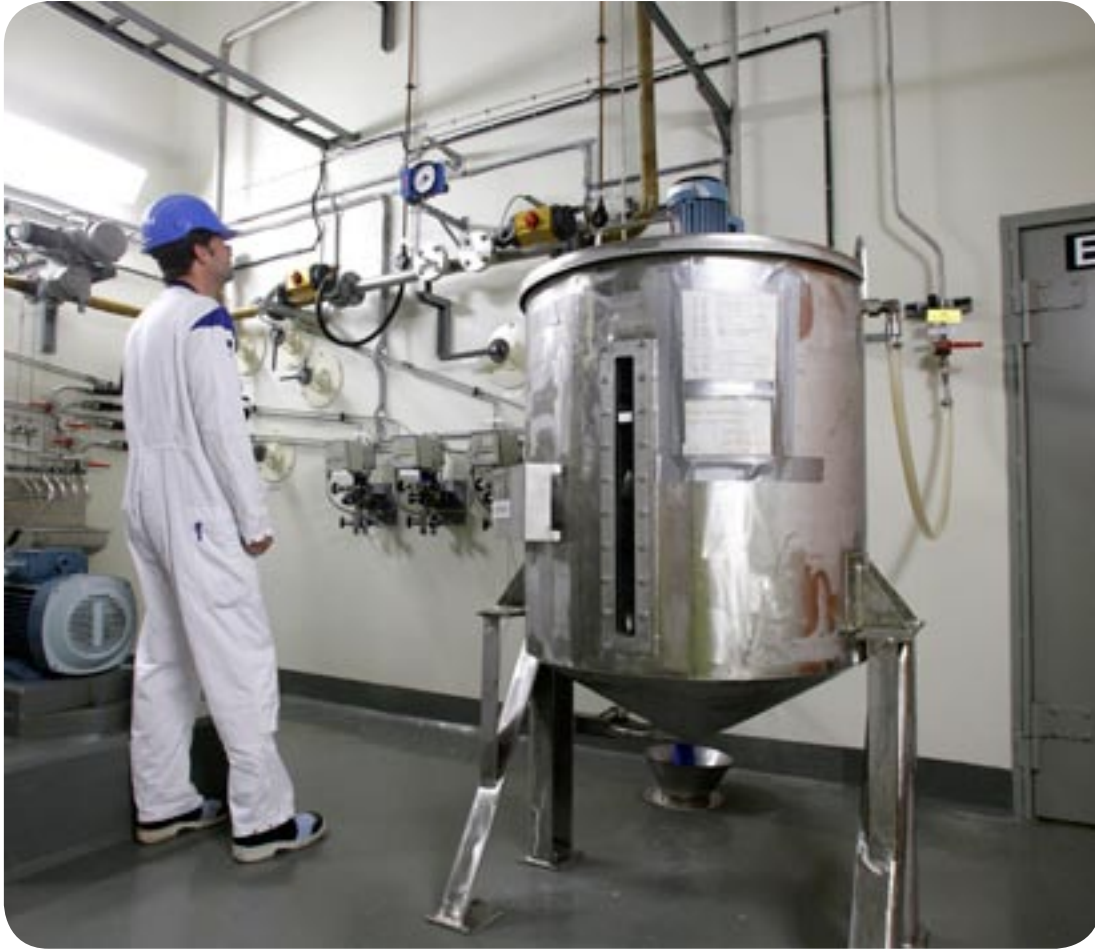
Figur 9-9. Kontroll och utflöde av processvatten i Clab.
