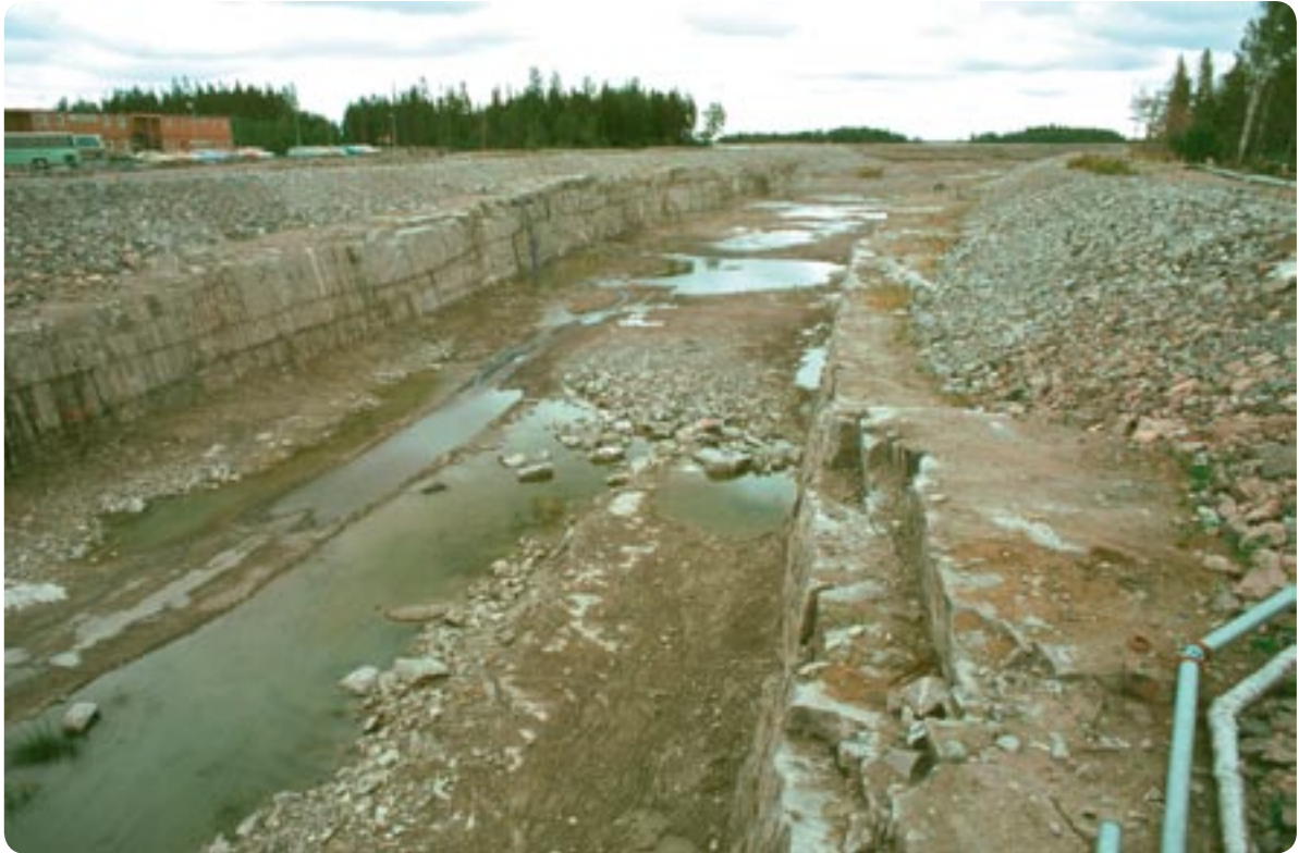
Figur 7-11. Exempel på hur de horisontella, vattenförande sprickorna i sprickdomän FFM02 ser ut nära ytan. Bild tagen vid anläggandet av kylvattenkanalen i Forsmark.
