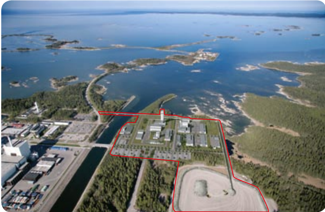
Figur 4-3. Slutförvarsanläggningen placeras vid Söderviken i Forsmark (fotomontage). Forsmarks kärnkraftverk skymtar till vänster. De röda markeringarna anger vad som är fotomontage. Ytan längst ner är bergupplaget.
