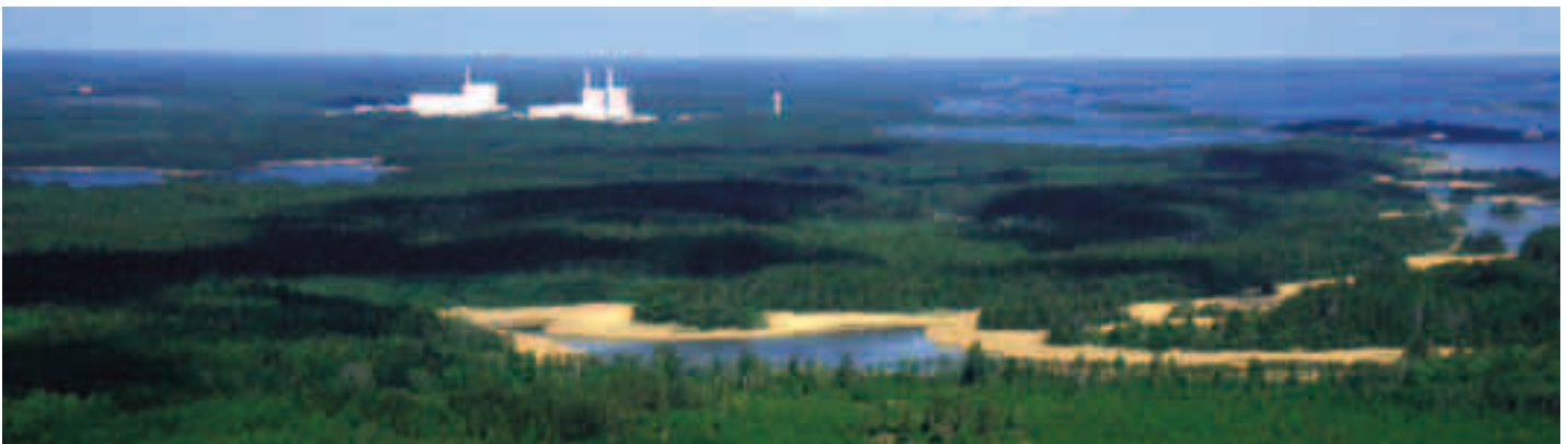
Forsmarks kärnkraftverk och delar av kandidatområdet.
