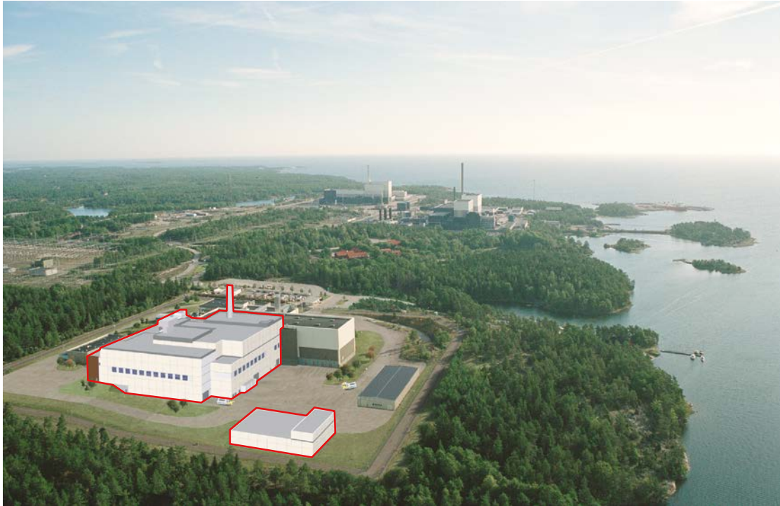
Figur 3-11. Clink med inkapslingsdel för använt kärnbränsle (markerad i figuren).
