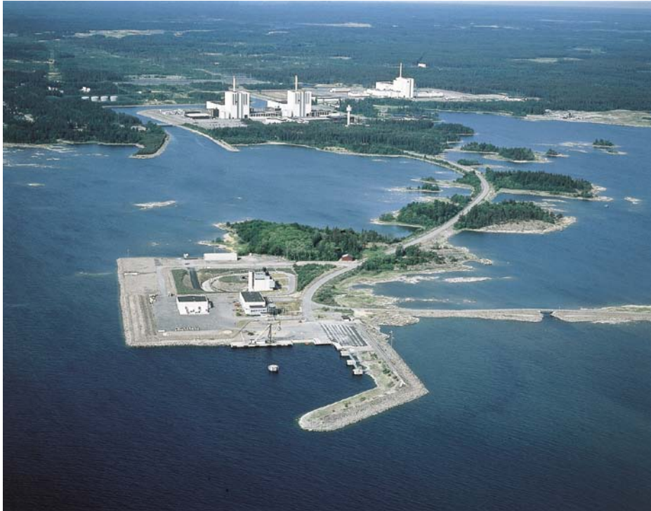
Figur 4-2. Flygfoto över SFR-anläggningens ovanmarksdel vid hamnen i Forsmark.
