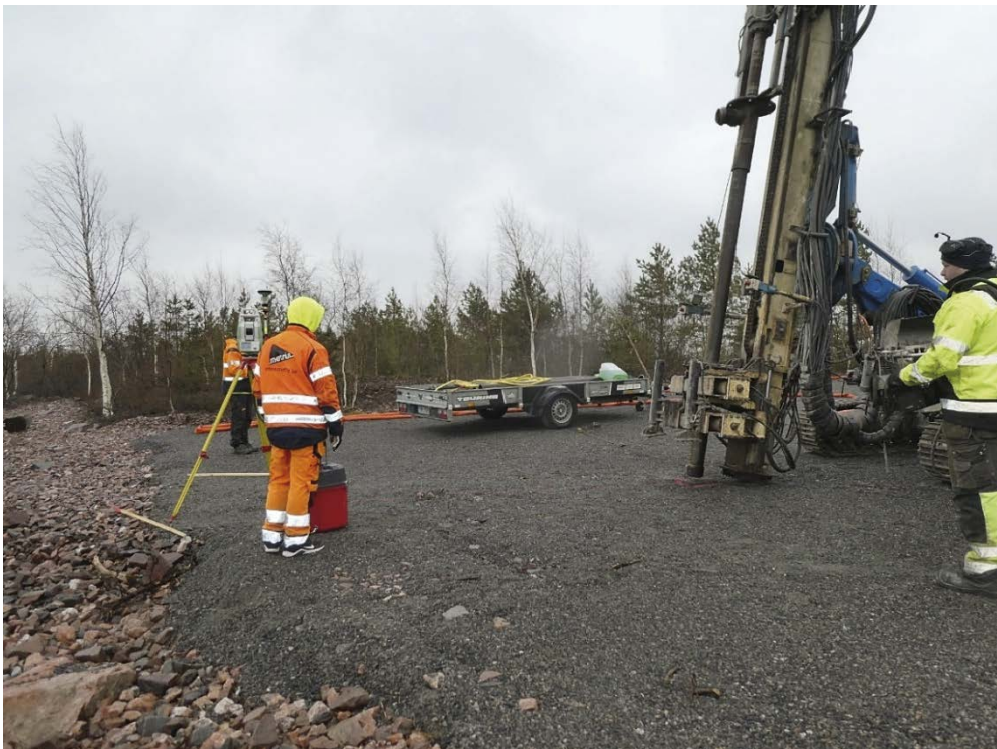
Figur 4-4. Metria orienterar foderröret och mäter även in startpunkten för borrhålet KFR117.
