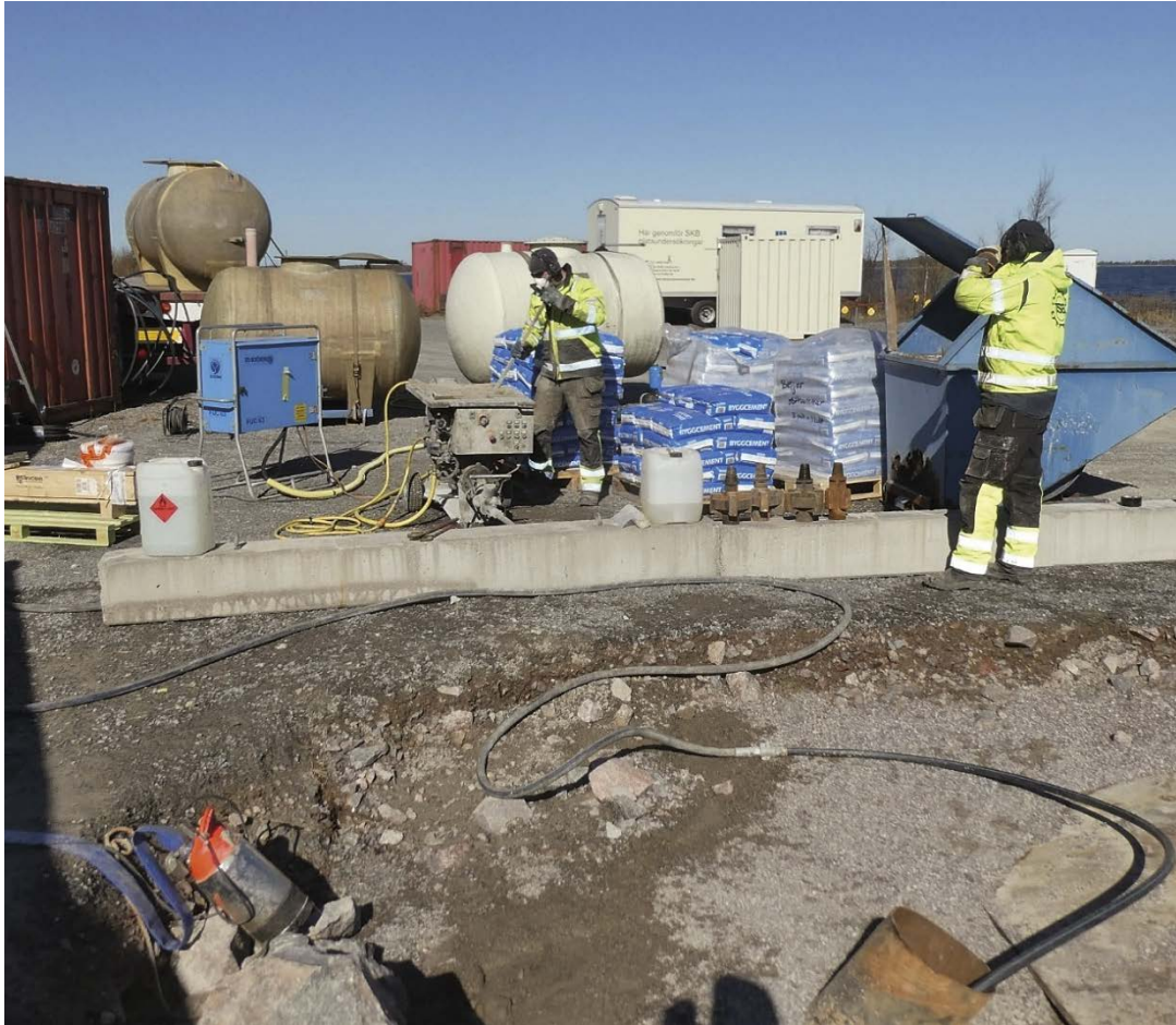
Figur 5-7. För att fylla upp hela teleskopdelen av KFR121 gick det åt 4 ton cement.
