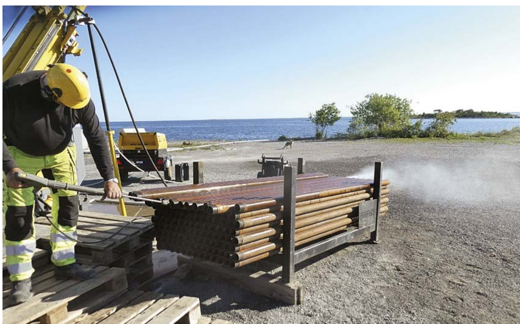
Figur 4-13. Borrhören spolas med hetvatten innan de används vid boringen.
