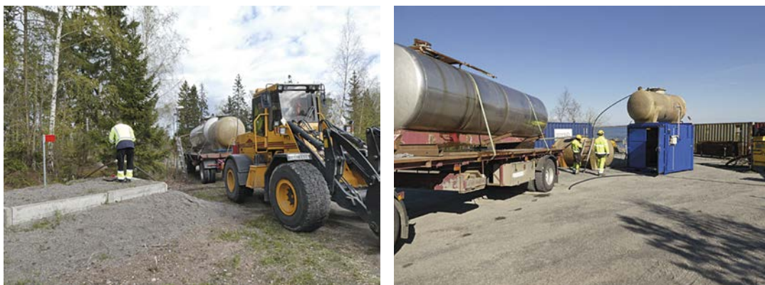
Figur 5-12. Till vänster: Dricksvatten från vattenposten som ligger intill vägen mellan kraftverket och SFR användes vid borrhningarna på piren. En transport som den på bilden räcker till ca 25 m kärnborrhning. Till höger: Från tankvagnen leds vattnet till en buffertank på marken varifrån vattnet pumpas upp till tanken på den blå mätcontainern. I mätcontainern tillför en flödesstyrad doserare spårämnet uranin (med en halt av 0,20 mg/L), innan spolvattnet når bormaskinen.
