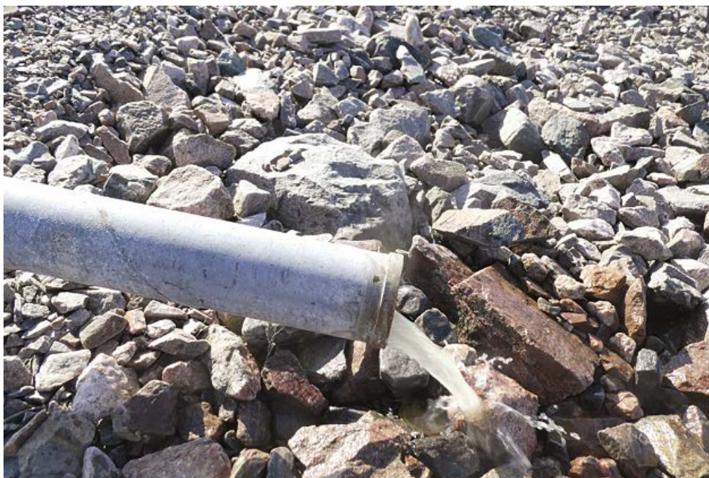
Figur 4-11. Efter sedimentation i två steg släpps returvattnet ut i strandkanten innan det når havet.
