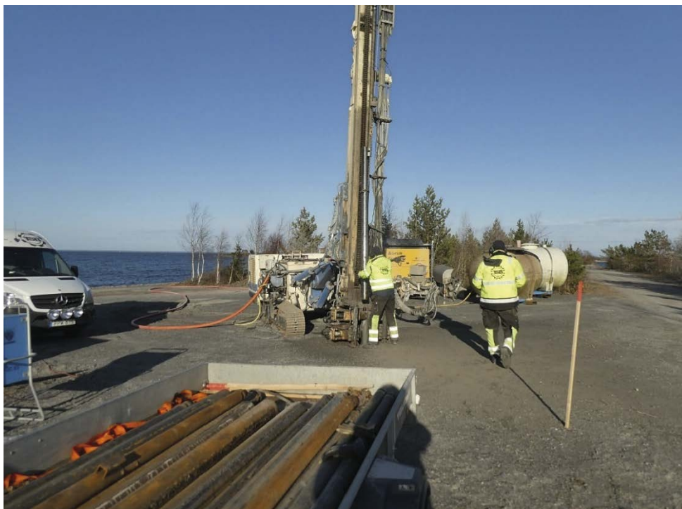
Figur 4-2. Hammarborrmaskin Soilmec SM-14 under drivning av foderrör genom bergfyllnaden för KFR119.
