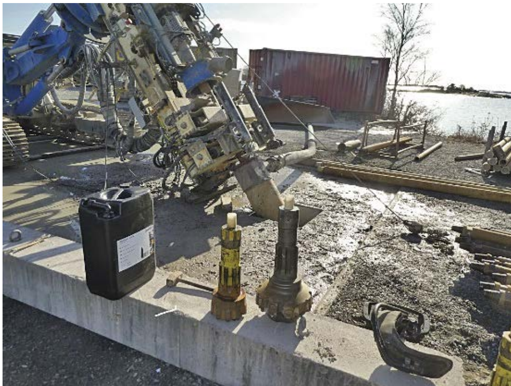
Figur 4-6. Det första grova foderröret (323/303 mm) är borrarat genom fyllnadsmassorna och ner i berg. I förgrunden ses två borkronor som sedan används för att pilotborra med 165 mm diameter och därefter rymma upp borrhålet till 248 mm diameter.
