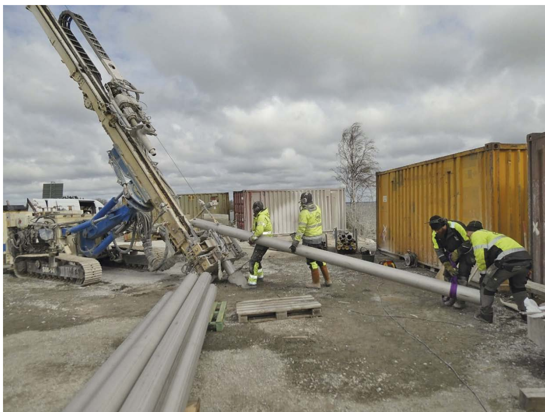
Figur 4-7. Montering av de rostfria foderrören i teleskopborrhålet KFR121.
