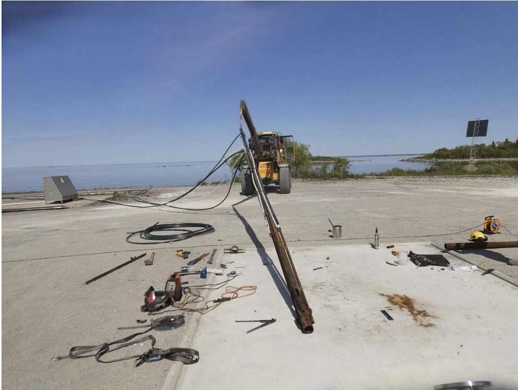
Figur 4-8. Montering av den första sektionen av det temporära yttre foderröret som är försett med två mammutpumpar och tillhörande blås- och returvattenslangar.
