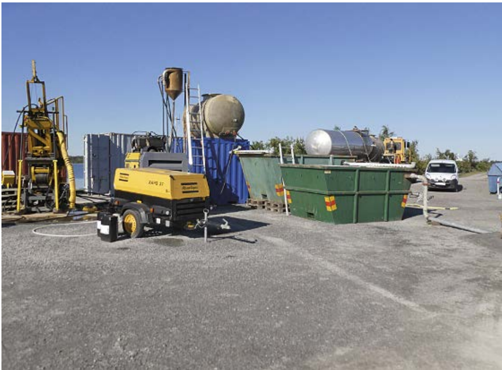
Figur 4-9. Borrplatsen för KFR121 med kringutrustningen uppställd runt bormaskinen.
