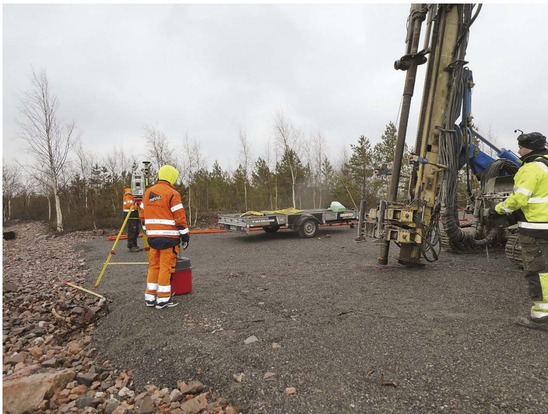
Figur 5-4. Inmätning med totalstation av foderröret vid förborrningen av KFR118.
