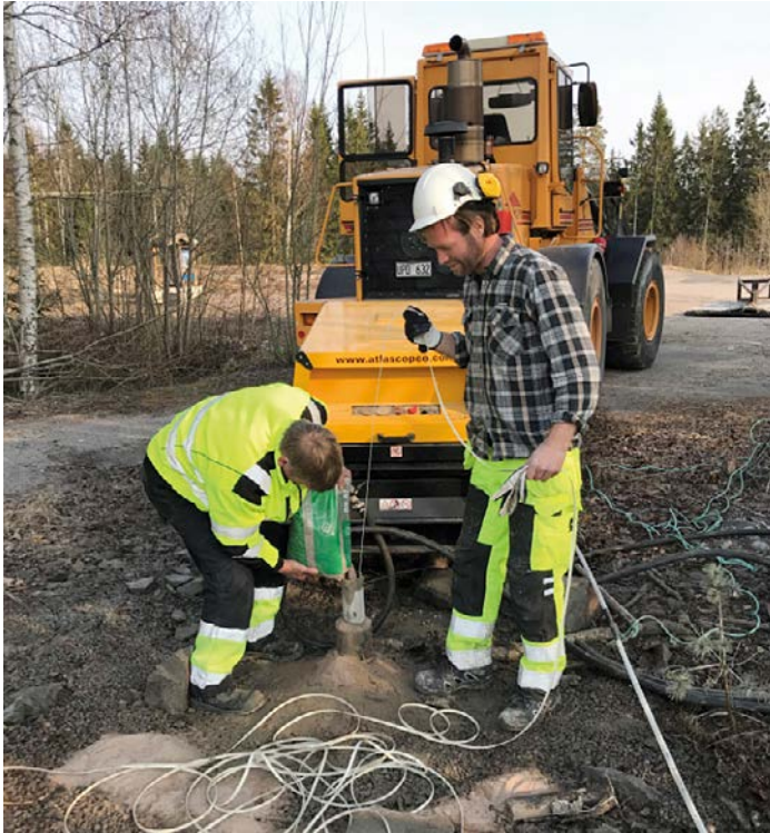
Figur 2-3. Proppning av hål med fogsand (KFM 18).
