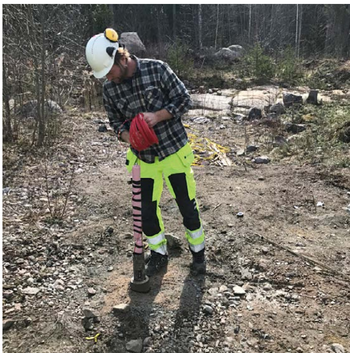
Figur 2-2. Laddning av borrhål, i detta fall 4 kg laddning (KFM 20).
