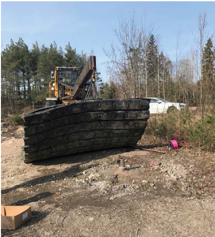
Figur 2-4. Täckning av laddat hål med tunga gummimattor (KFM 20).
