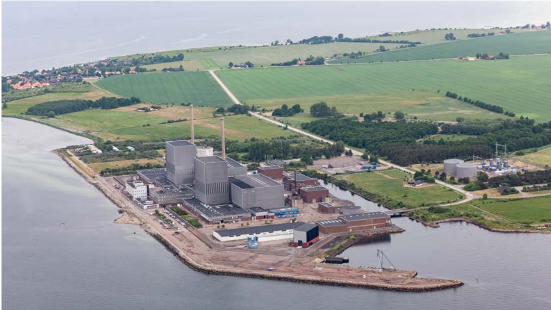
Figur 16-1. Vy över Barsebäcks kärnkraftverk med de två BWR-reaktorerna B2 (närmast i bild) och B1. Foto Jenny Eliasson, Malmö Museer.
