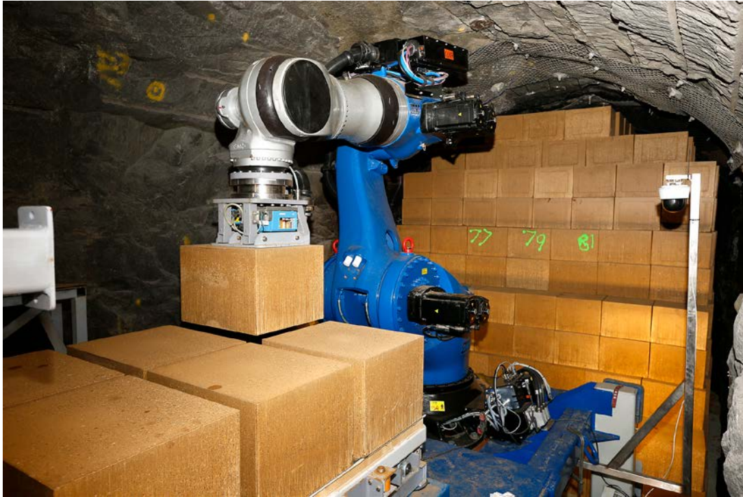
Figur 11-15. Blockinstallation på 450 meters djup vid Äspölaboratoriet.
