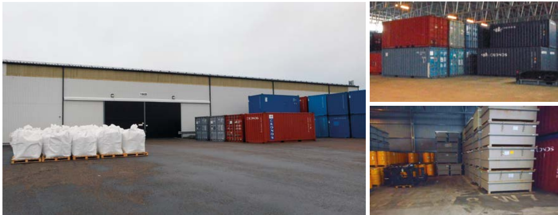
Figur 3-7. Oves Lada, uppställningsyta för bland annat mycket lågaktivt avfall vid Ringhals kärnkraftverk.
