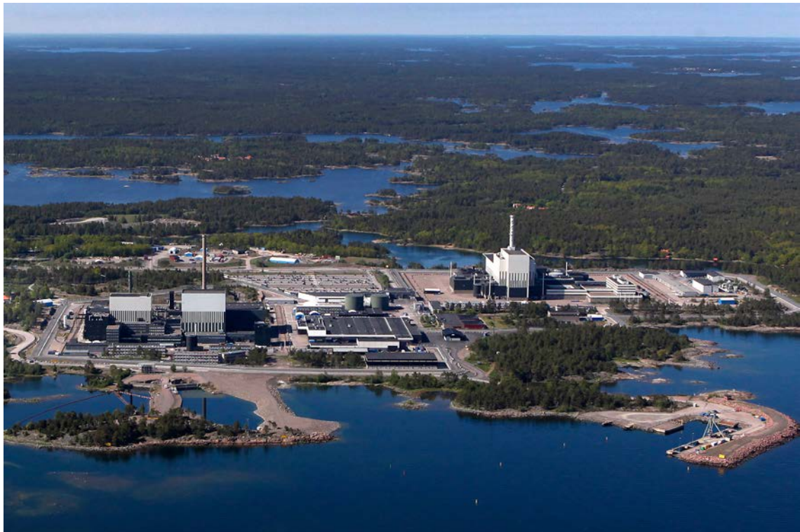
Figur 16-3. Vy över OKG:s kärnkraftverk med de tre BWR-reaktorerna O1, O2 och O3 från vänster till höger i bild.
