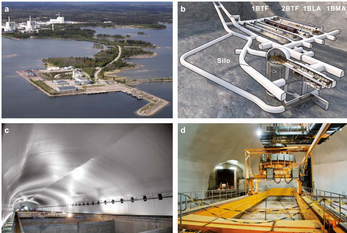
Figur 2-3. Slutförvaret för kortlivat radioaktivt avfall, SFR, består av två bergssalar för betongtankar (1-2BTF), en bergssal för lågaktivt avfall (1BLA), en bergssal för medelaktivt avfall (1BMA) och en silo för medelaktivt avfall. a) Vy över ovanmarksdelen, b) SFR under mark, c) bergssal, d) vy över silotopp.
