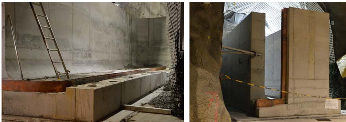
Figur 10-3. Kassunsektion 1 omfattande bottenplatta och L-formad vägg (till vänster) samt kassunsektion 2 omfattande L-formad vägg vilken uppförts på bottenplattan till sektion 1.
