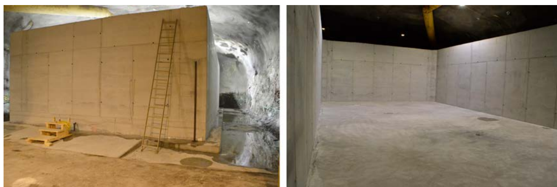
Figur 10-4. Gjuten kassun, ut- och insida.
