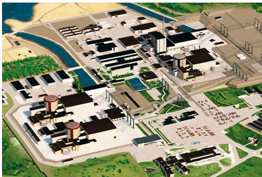
Figur 17-1. Ringhals kärnkraftverk med reaktor 1 och 2 till höger i figur och reaktor 3 och 4 till vänster. I centrum av förlägningsplatsen finns bland annat kontorslokaler och lunchrestaurang. Strax ovanför R1 i bilden syns verkets avfallsområde vilket inkluderar hantering, konditionering och lagring av kärnavfall.
