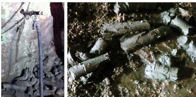
Figur 2-9. Uttryckt injekteringsmedel, där injekteringsmedlet är en mjuk sammanhållande massa trots en lång väntetid.
