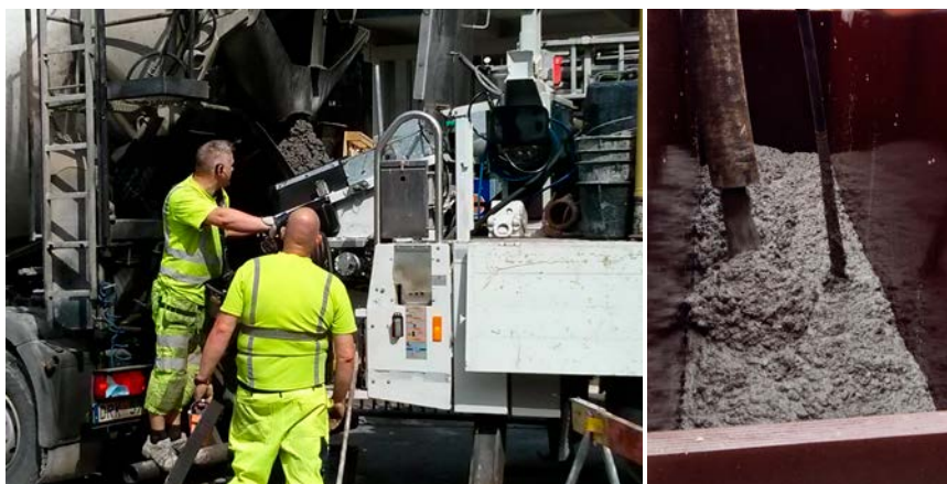
Figur 8-1. Betongen överförs till pumpbilen och pumpas i formen. Notera i den vänstra bilden hur en hög med styv betong ansamlats på gallret över pumpbaljan samt betongens begränsade utflytning i den högra bilden.
