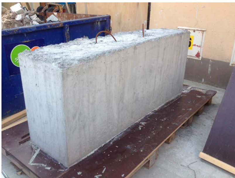
Figur 8-2. Betongmonoliten efter avformning.
