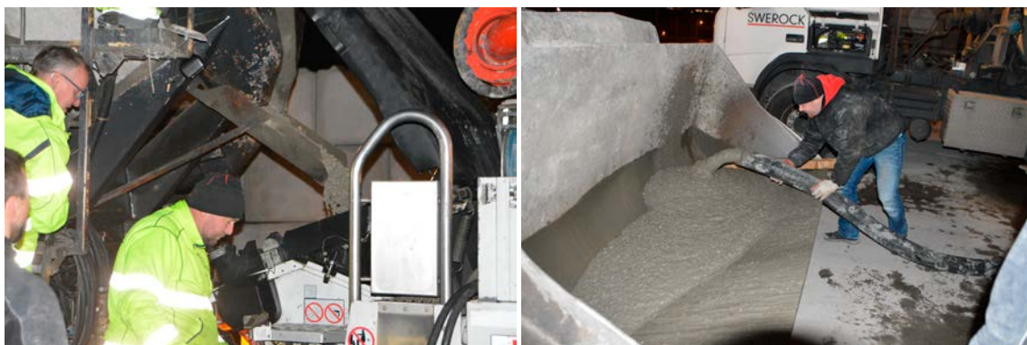
Figur 8-5. Betongen överförs till pumpbilen (t.v.) och pumpas (t.h.)
