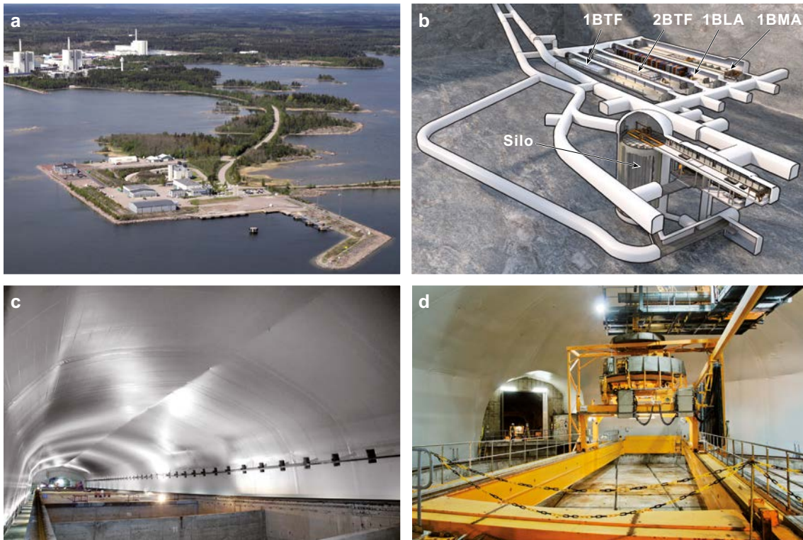
Figur 2-2. Slutförvaret för kortlivat radioaktivt avfall, SFR består av två bergssalar för betongtankar (1–2BTF), en bergssal för lågaktivt avfall (1BLA), en bergssal för medelaktivt avfall (1BMA) och en silo för medelaktivt avfall. a) Vy över ovanmarksdelen, b) SFR under mark, c) bergssal, d) vy över silotopp.
