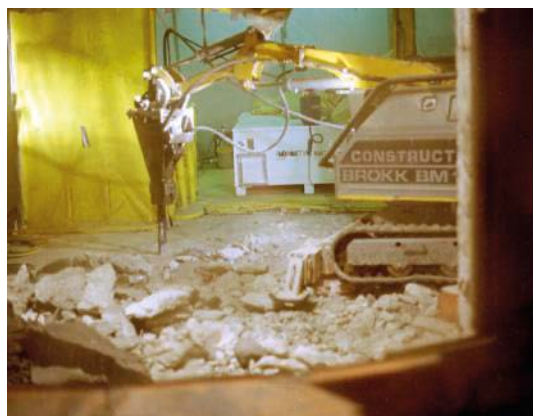
Figur 4-29. Transport av aktivt betongblock från biologiska skärmen och betongkross producerat med en hydraulisk hammare.
