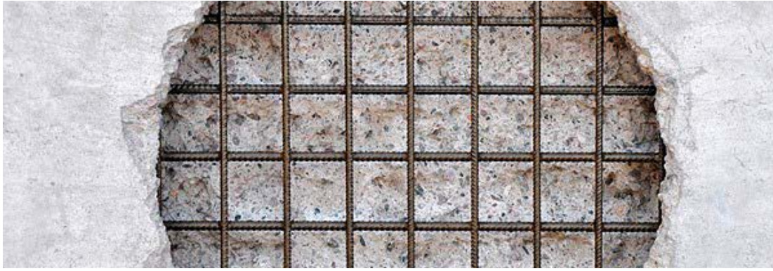
Figur 4-8. Armerad betong efter vattenbilning.
