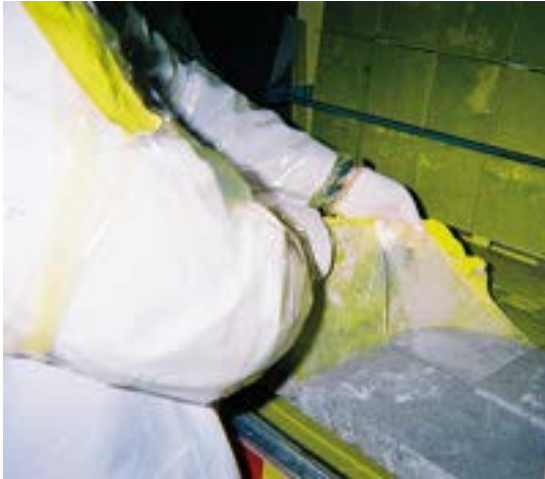
Figur 4-11. Avlägsnande av Stripcoat TLC Free.
