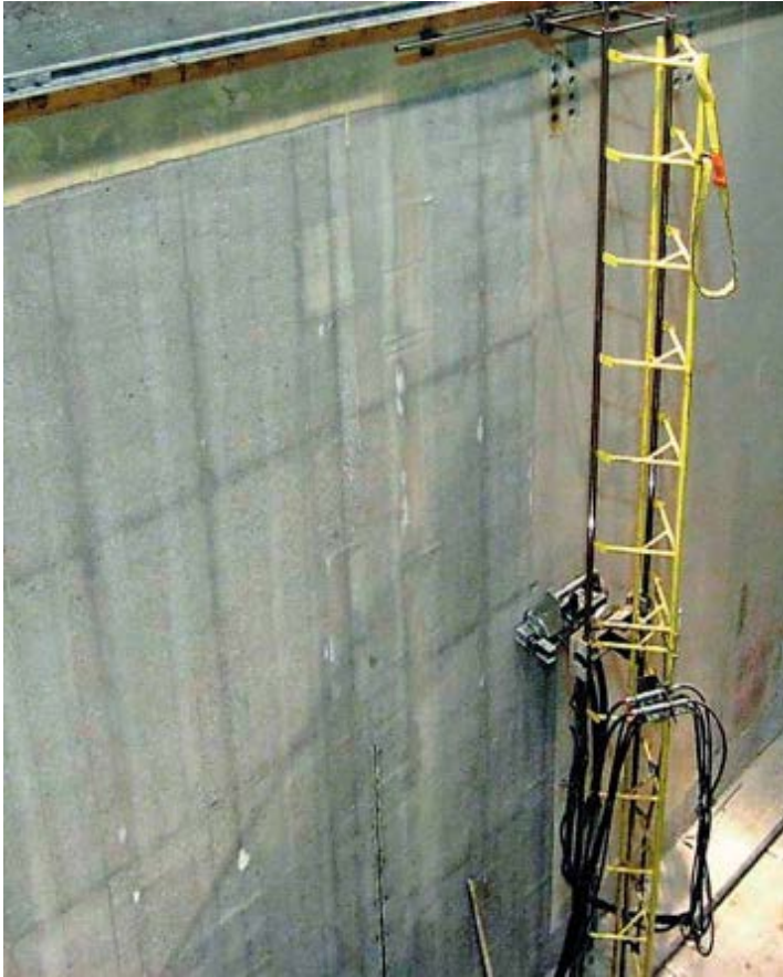
Figur 4-21. Ram för rälsstyrd väggshaver.
