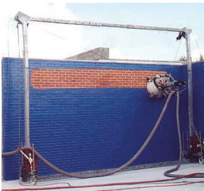
Figur 4-17. Rammonterad och automatiserad scabblar.
