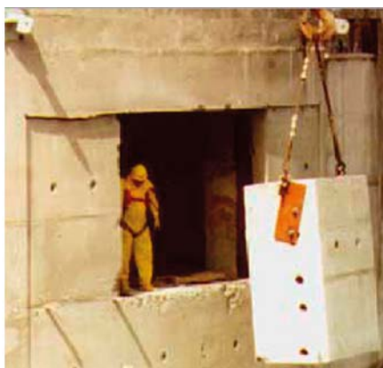
Figur 4-29. Transport av aktivt betongblock från biologiska skärmen och betongkross producerat med en hydraulisk hammare.
