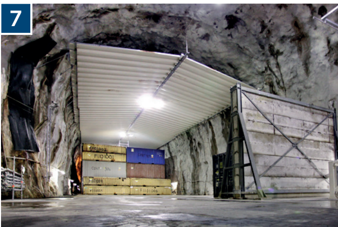
7 Det lågaktiva avfallet förvaras i vanliga containrar som hanteras med gaffeltruck.
