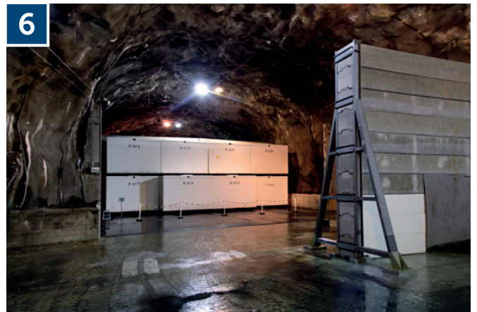
6 Sal för medelaktivt avfall i betongtankar. Tankarna hanteras med gaffeltruck.
