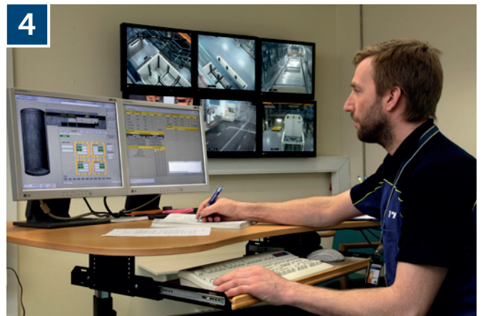
4 I kontrollrummet övervakas och fjärrstyrs traverserna och urlastningen av transportbehållarna.
