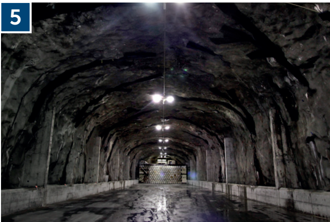
5 I den här salen förvaras medelaktivt avfall som gjutits in i betongcylindrar och hanteras med gaffeltruck.
