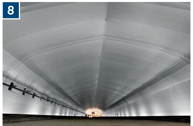
8 I den här bergssalen förvaras medelaktivt avfall i fat eller kokiller. Hanteringen sköts med travers, som övervakas i kontrollrummet.
