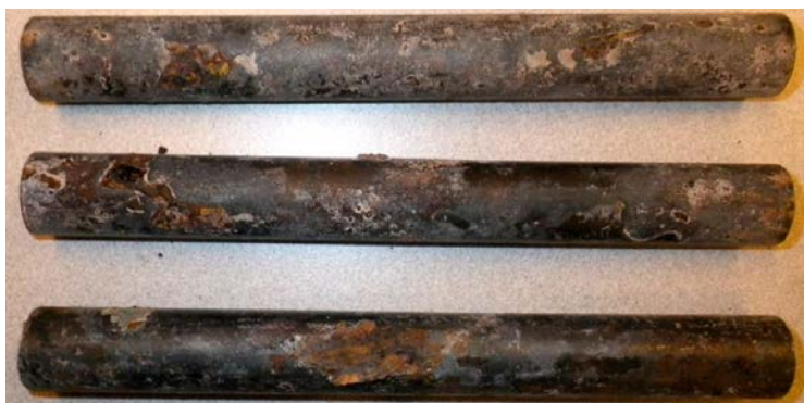
Figur 4-8. Stålstänger ingjutna i anläggningsbetong med ingjutna klorider efter fem års exponering i Äspötunneln (Sederholm et al. 2014).
