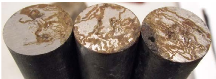
Figur 4-5. Stålstänger som varit ingjutna i låg-pH-betong utan klorider efter fem års exponering i Äspölaboratoriet (Sederholm et al. 2014).
