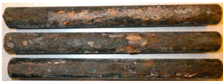
Figur 4-6. Stålstänger som varit ingjutna i anläggningsbetong exponerad för kloridlösning efter fem år i Äspölaboratoriet (Sederholm et al. 2014).
