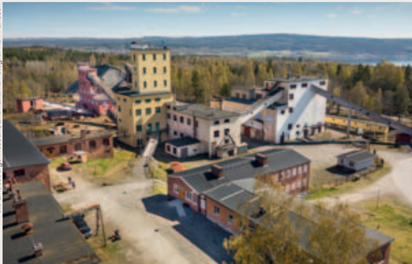
I Stripa gruva började den svenska forskningen kring slutförvaring av använt kärnbränsle. Gruvområdet restaureras nu för att bevaras för framtiden.
