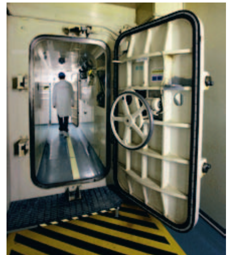
För att få träda in i det allra heligaste, reaktorhallen, måste man passera genom en personsluss.
