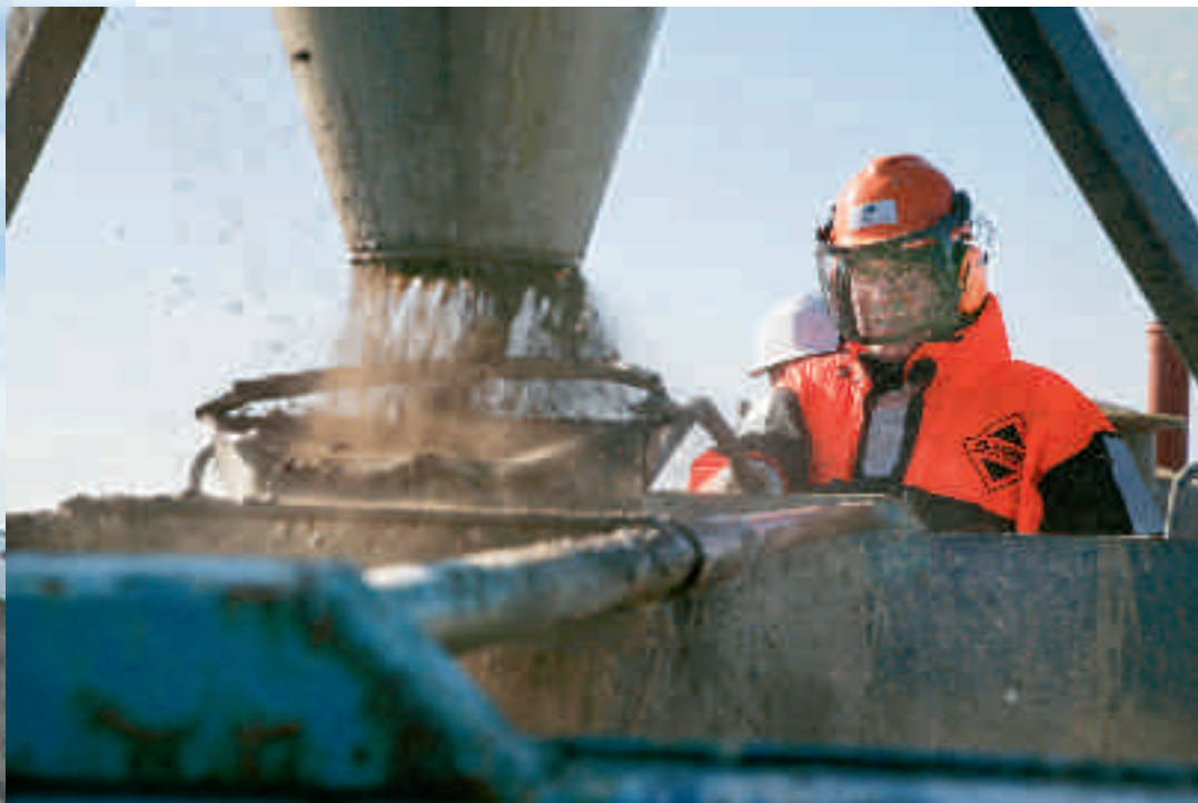
Kenneth Åkerström vid bormaskinen får lerinpackning på arbetstid ...
