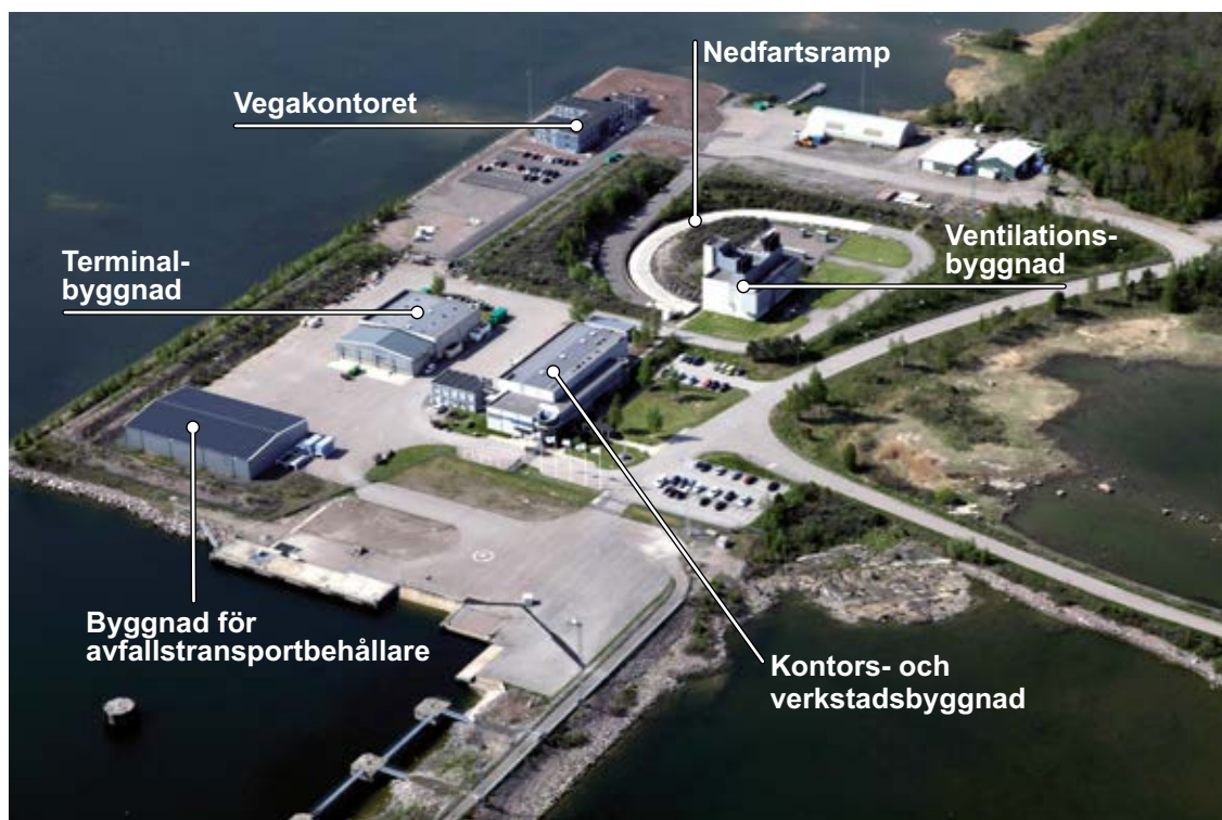
Figur 7-1. SFR:s ovanjordsanläggningar. På bilden syns även SKB:s kontor Vega och Forsmarks hamn.
