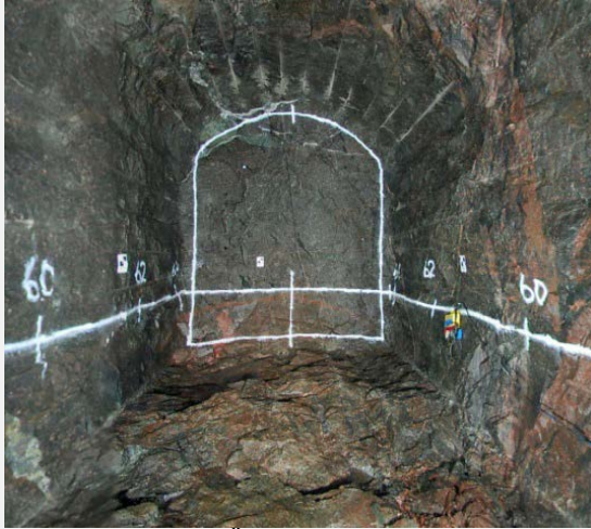
The Tass-tunnel in Äspö HRL.
