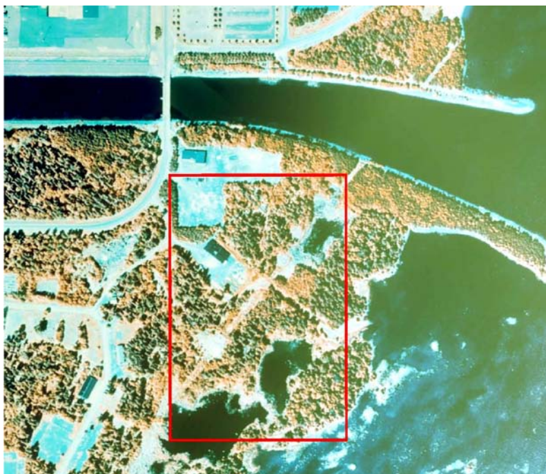
Figur 2-1. Ortofoto över driftområdet (röd ram; se även översiktskartan i figur 1-1). De tre vattenområden som kommer att fyllas igen syns som mörka fält i driftområdets nordöstra och södra del /SKBdoc 1193657/. Området inom den röda ramen har en yta på 224 m gånger 336 m.
