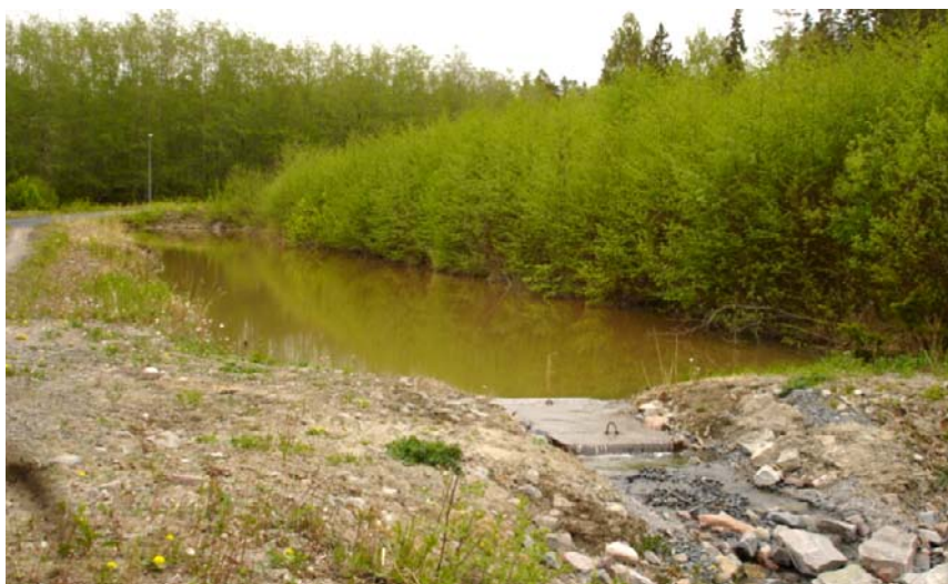
Figur 5-3. Rudimentdiket, norr om infartsvägen mot kärnkraftverket.
