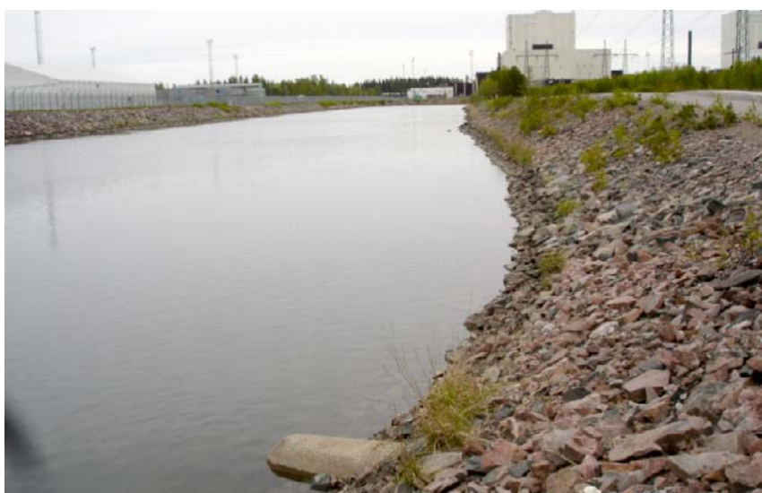
Figur 5-4. Dikets mynning (betongtrumman i bilden) vid FKA:s kylvattenkanal.
