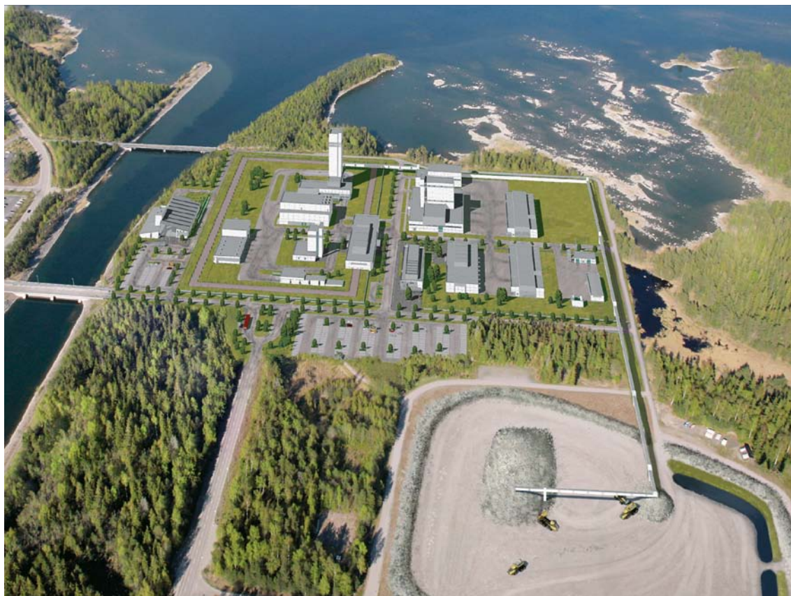
Figur 6-29. Anläggningen vid uppförandeskedets slut.
