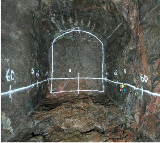
The Tass-tunnel in Äspö HRL.
