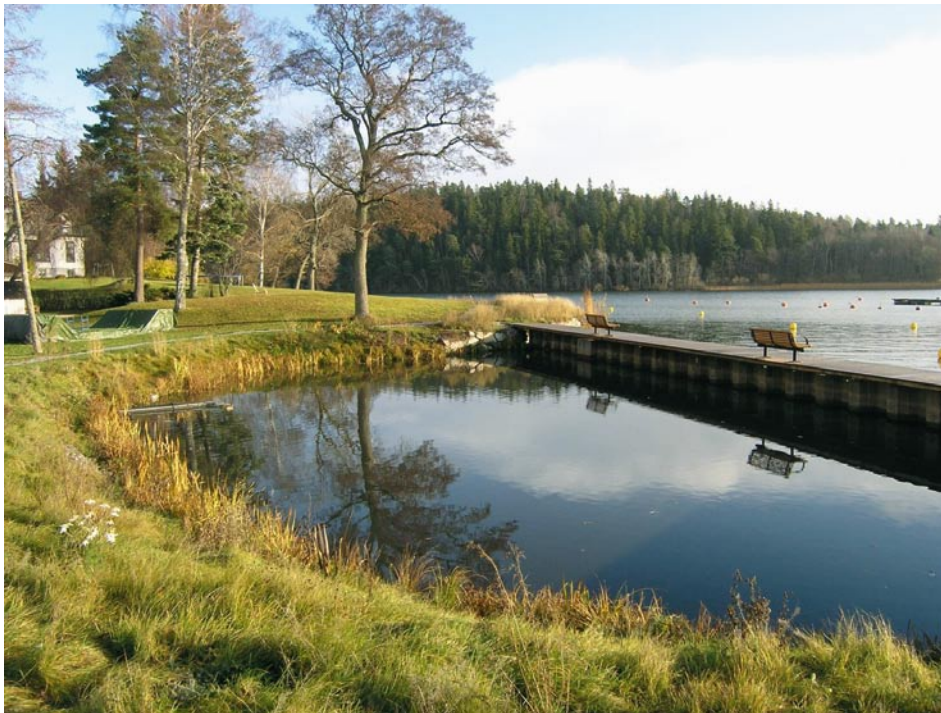
Figur 5-8. Ett exempel på en dagvattendamm med stålspontad vägg som dolts under en brygga (Kungsängen, Upplands Bro kommun). Foto WRS.
