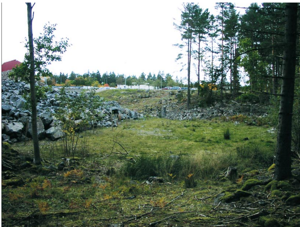
Figur 5-2. Sänkan på bilden anpassas enligt huvudförslaget till en damm för rening av dagvatten från kvarvarande hårdgjorda ytor inom Clab efter att förebyggande åtgärder vidtagits. Foto D. Stråe.
