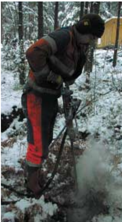
Figur 6. Reflektionsseismik. a) Borrning av laddningshål i jord med tryckluftdriven bormaskin. b) Servicebil för borrning av laddningshålen. Terränglastbilen drar kompressorn. Foto Hans Palm, Uppsala Universitet.
