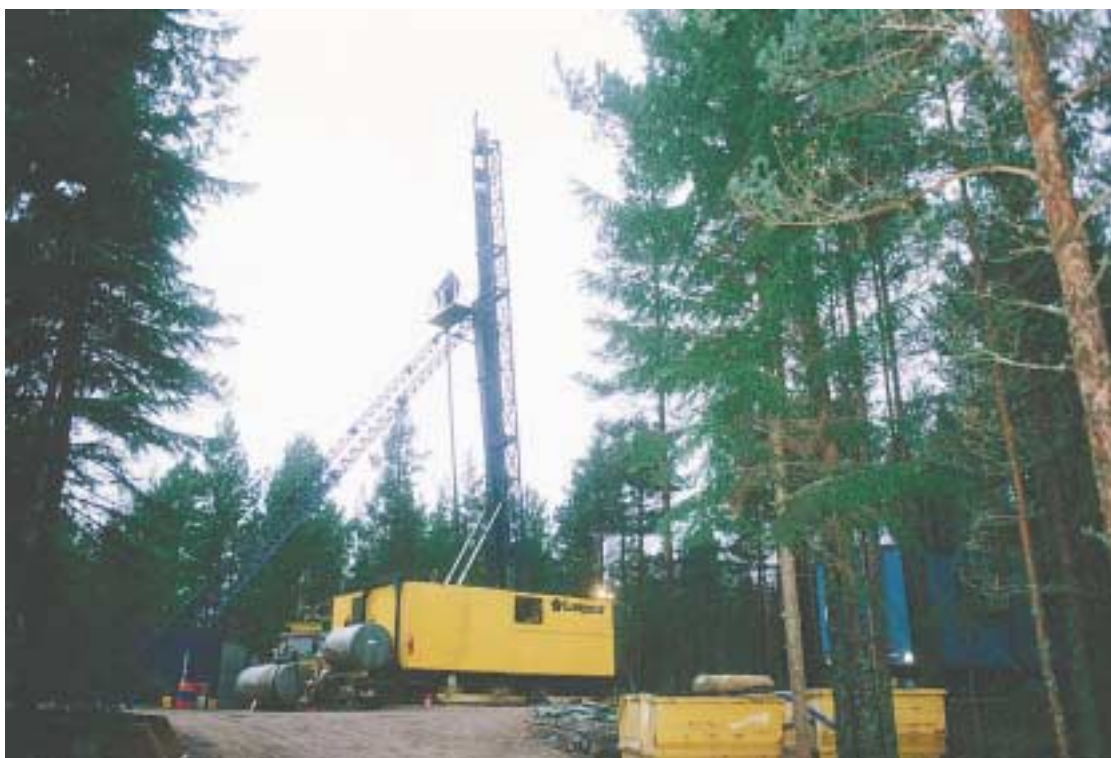
Figur 9. Kärnborrning på en iordningställd borrplats med väganslutning.
