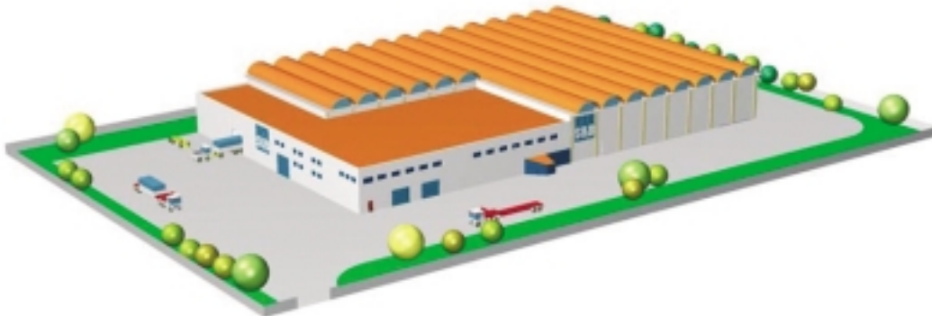
Figur 8-1. Exteriör av SKB:s kapsel­fabrik.
