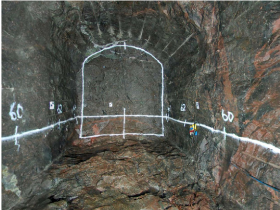
Tass-tunnel in Äspö HRL
