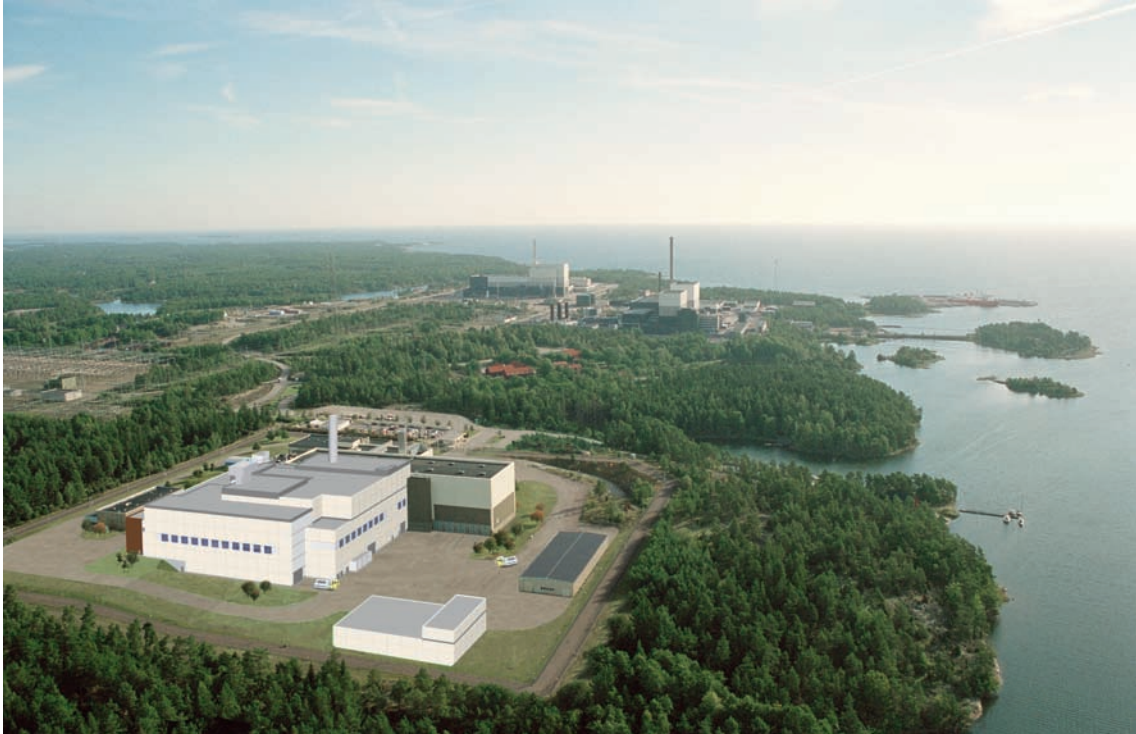
Figur 2-8. Inkapslingsanläggning för använt kärnbränsle sammanbyggd med Clab.
