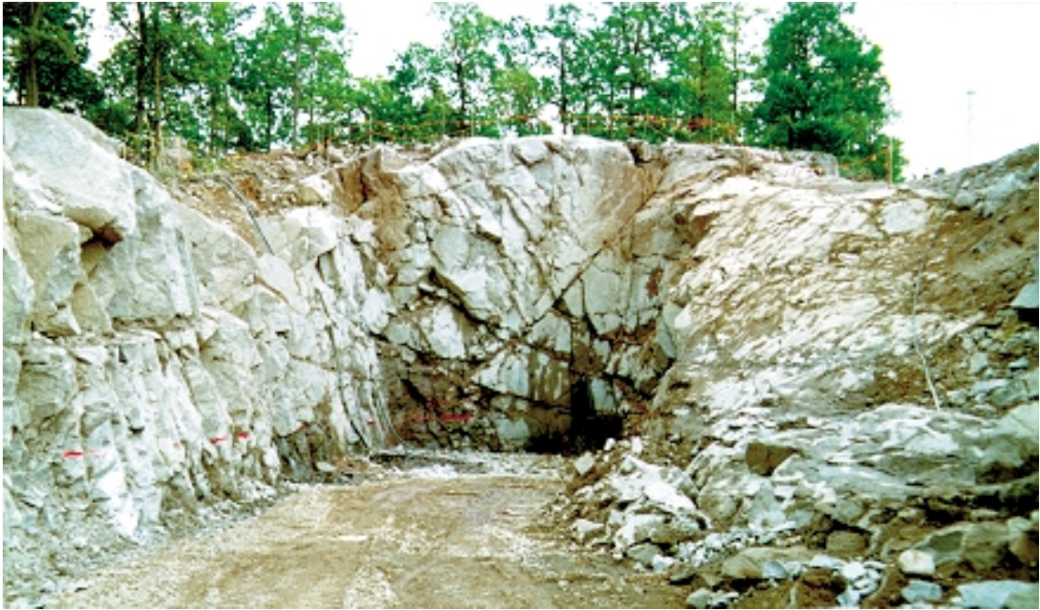
Figur 4-3. Byggnation av tunnel till Äspölaboratoriet.
