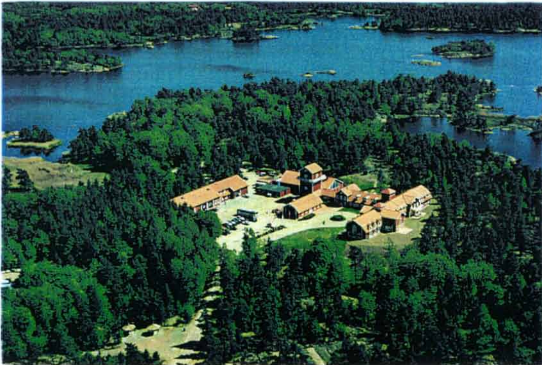
Figur 7-1. Åspölaboratoriet ovan och under jord.
