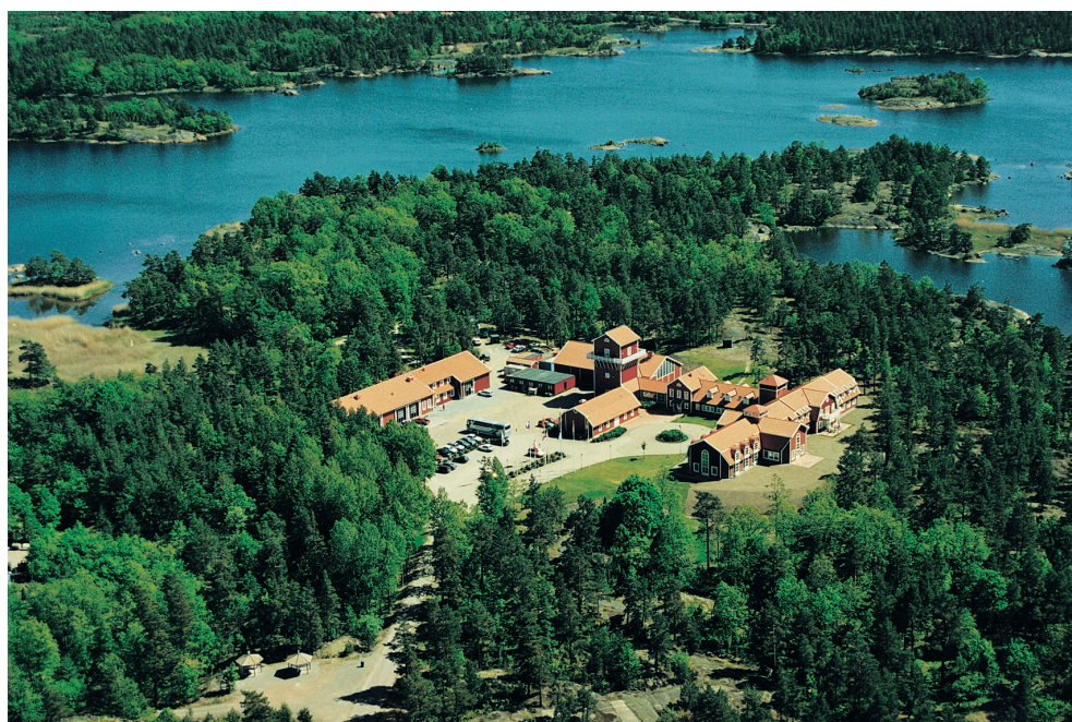
Figur 9-2. Vid Äspölaboratoriet bedrivs en stor del av SKB:s tillämpade forskning och teknikutveckling.
