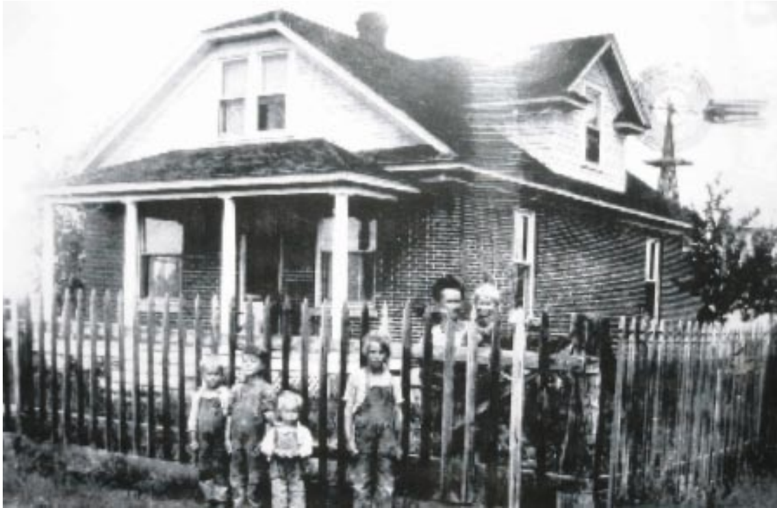
Familjen Egri (?) framför det hus som fortfarande finns kvar som ett kulturminne på Rocky Mountain Test Site.
