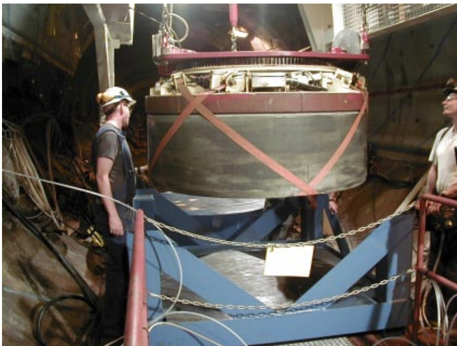
Figur 5-3. Ett bentonitblock lyfts för vidare nedsättning i deponeringshålet.
