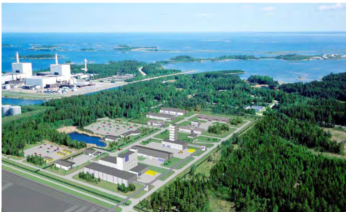
Figur 1-2. Bildmontage som visar hur de tänkta anläggningarna för ett slutförvar kan placeras i Forsmark.
