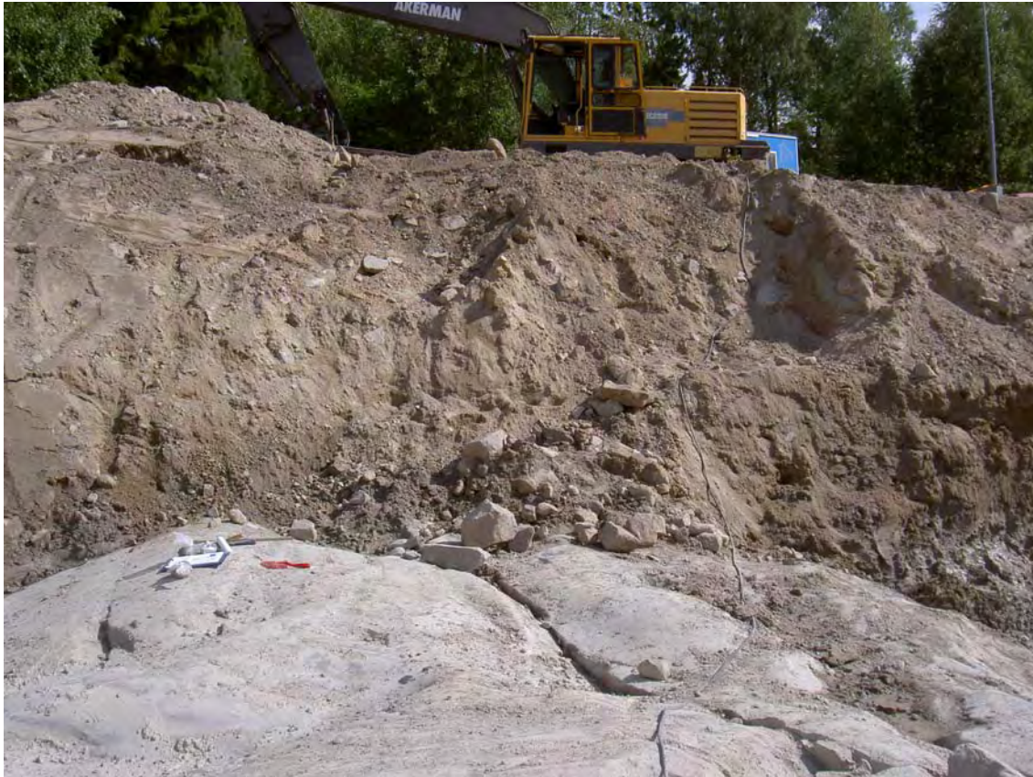
Figur 7. Fotografi 6, östra väggens södra del.
