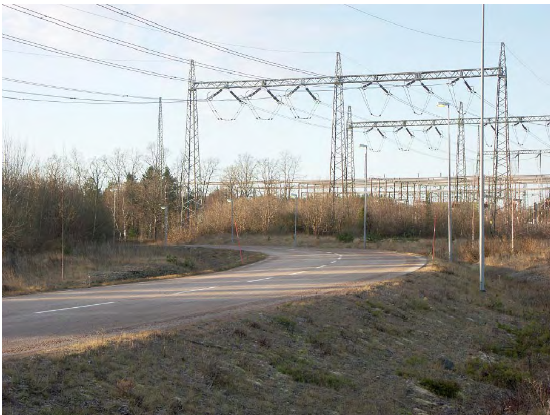
Figur 4-7. Storskalighet och dominans i byggnader, kraftledningarna och vägar präglar området.
