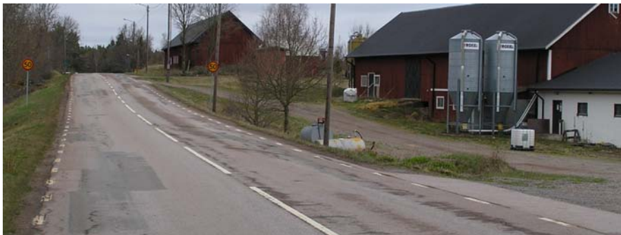
Sikt norrut på väg 743 strax före korsning i Lilla Laxemar. Korsningen är belägen strax efter vägkrönet.
